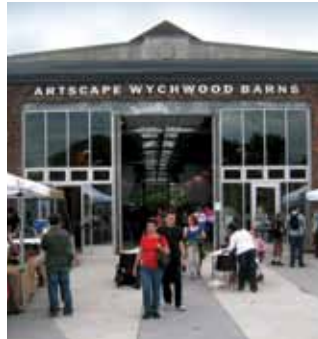
Réaménagement des ateliers d'entretien des tramways de la TTC, 2008
