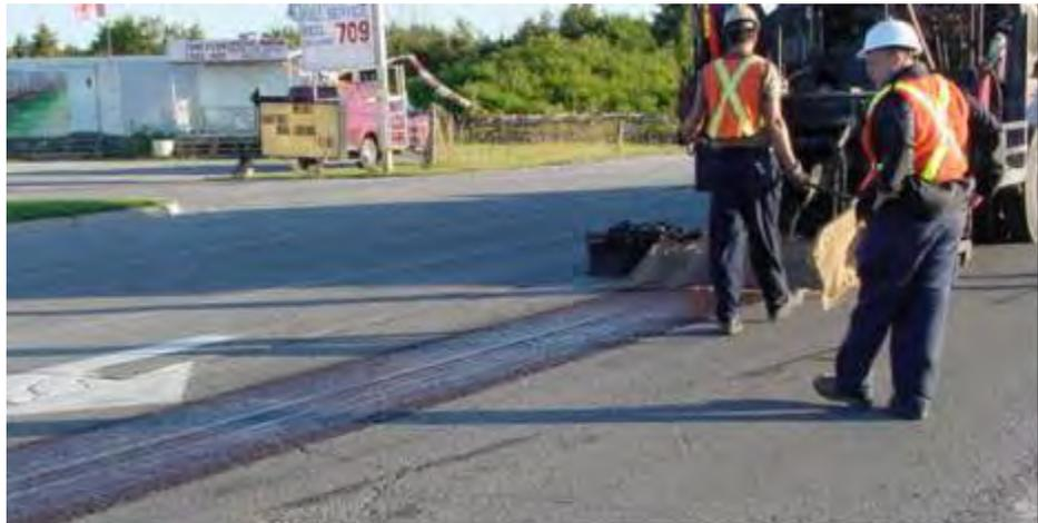
**Figure 3-8 : Le prétraitement de faïençage modéré à la ligne médiane avec une bande de microrevêtement avant l'application d'une assise régulière de microrevêtement sur toute la surface. (Gracieuseté du ministère des Transports de l'Ontario.)**
