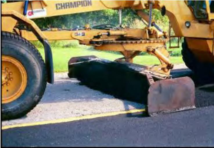
**Figure 3–2 : L'application d'une couche d'éraflée d'un mélange à chaud de haute densité par une niveleuse munie d'un attachement ayant l'apparence d'une boîte. (Gracieuseté du ministère des Transports de l'Ontario)**
