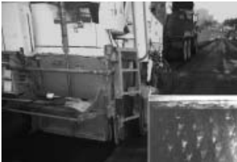
Photo 4-1 : Fraisage de précision destiné à éliminer l'orniérage dû à l'instabilité des enrobés
