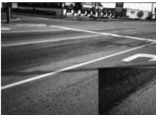
Photo 2-1 : Orniérage du béton bitumineux d'une chaussée souple classique de route de liaison municipale
