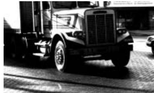
Photo 4-6 : Pavés de béton autobloquants utilisés pour reconstruire une rue municipale
