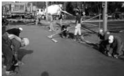
Photo 4-5 : Pose d'un revêtement superficiel de béton de fibres sur une intersection de route de liaison municipale
