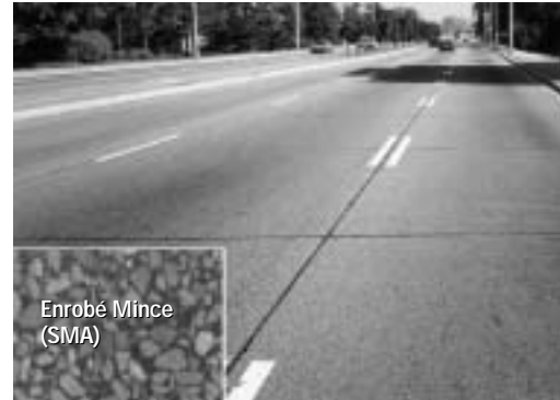
Photo 4-4 : Revêtement composite de route municipale reconstruit, avec couche de roulement en enrobé mince (SMA)
