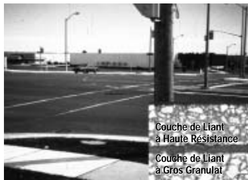
Photo 4-3 : Revêtement souple et résistant en profondeur d'une intersection de route municipale, reconstruit
